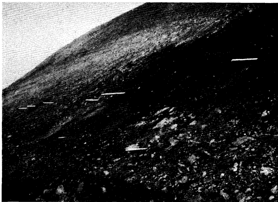
Foto 10. Corta Sabero Ocho.- Sistema de drenaje en el talud de muro (talud N).
