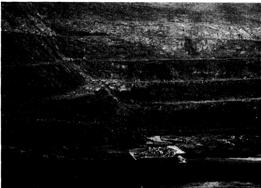
Foto 6. Corta Sabero Ocho.- Vista hacia el E del talud Sur.
