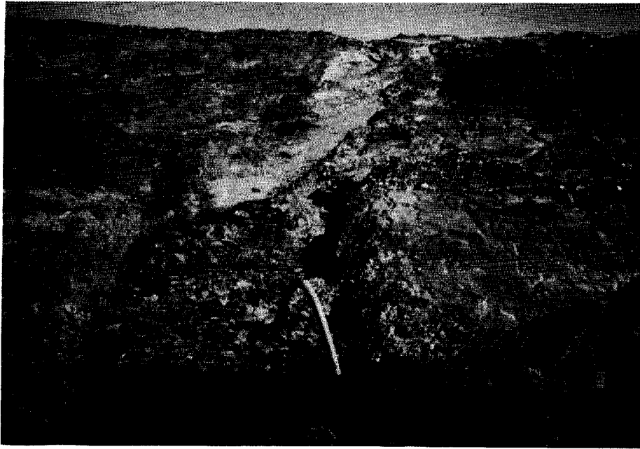
Foto 27. Corta Cervantes.- Pequeño deslizamiento a favor de una excavación hecha para un sondeo de drenaje, en el talud N.
