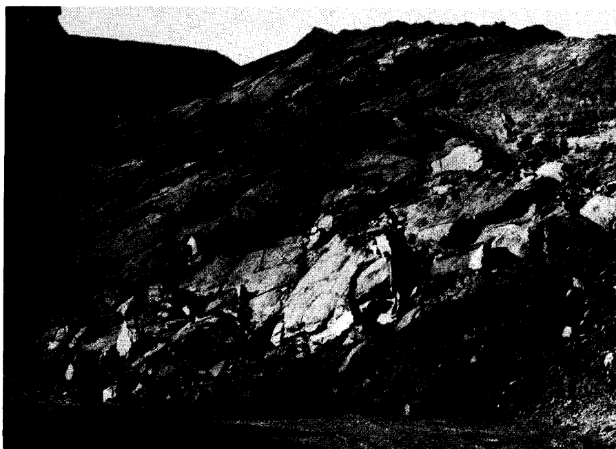
Foto 16. Coto Bello.- Deslizamiento de un talud de muro.
