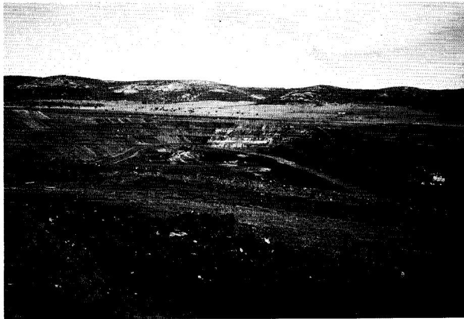
Foto 24. Corta Emma.- Vista general de la explotación desde el talud S. Se observan los taludes E (de avance), O (conformado por la escombrera) y N, con el banco superior excavado en materiales pliocuaternarios.
